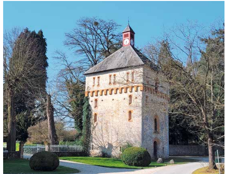
Die Bauernburg am Gut Barkhausen.
